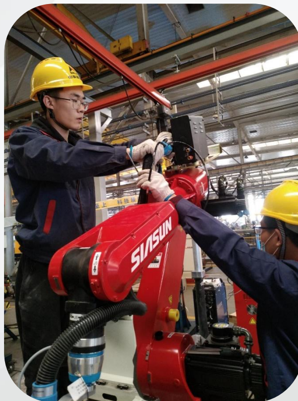
机器人安装调试
